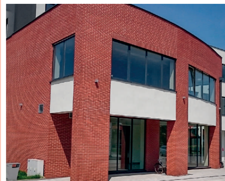
Centrum Aktywizacji Zawodowej w Zatorze – w całym budynku zainstalowane są klimakonwektory, które zimą ogrzewają pomieszczenia, a latem je chłodzą
