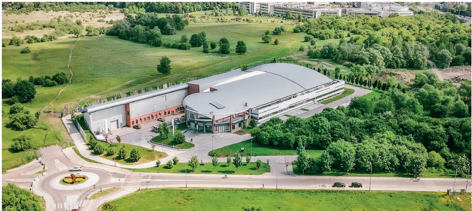
Narodowe Centrum Promieniowania Synchrotronowego SOLARIS w Krakowie
